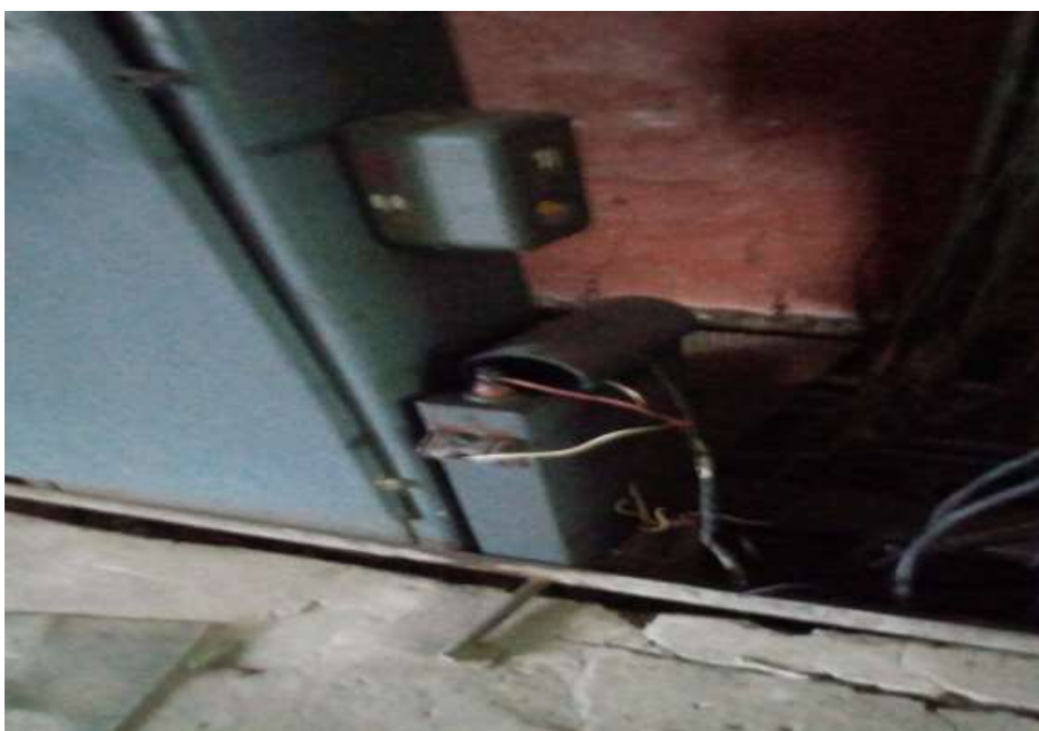
Imaginea nr. 5. Element al instalației de condensatoare de la stația de Epurare, str. V. Cupcea 5A.
