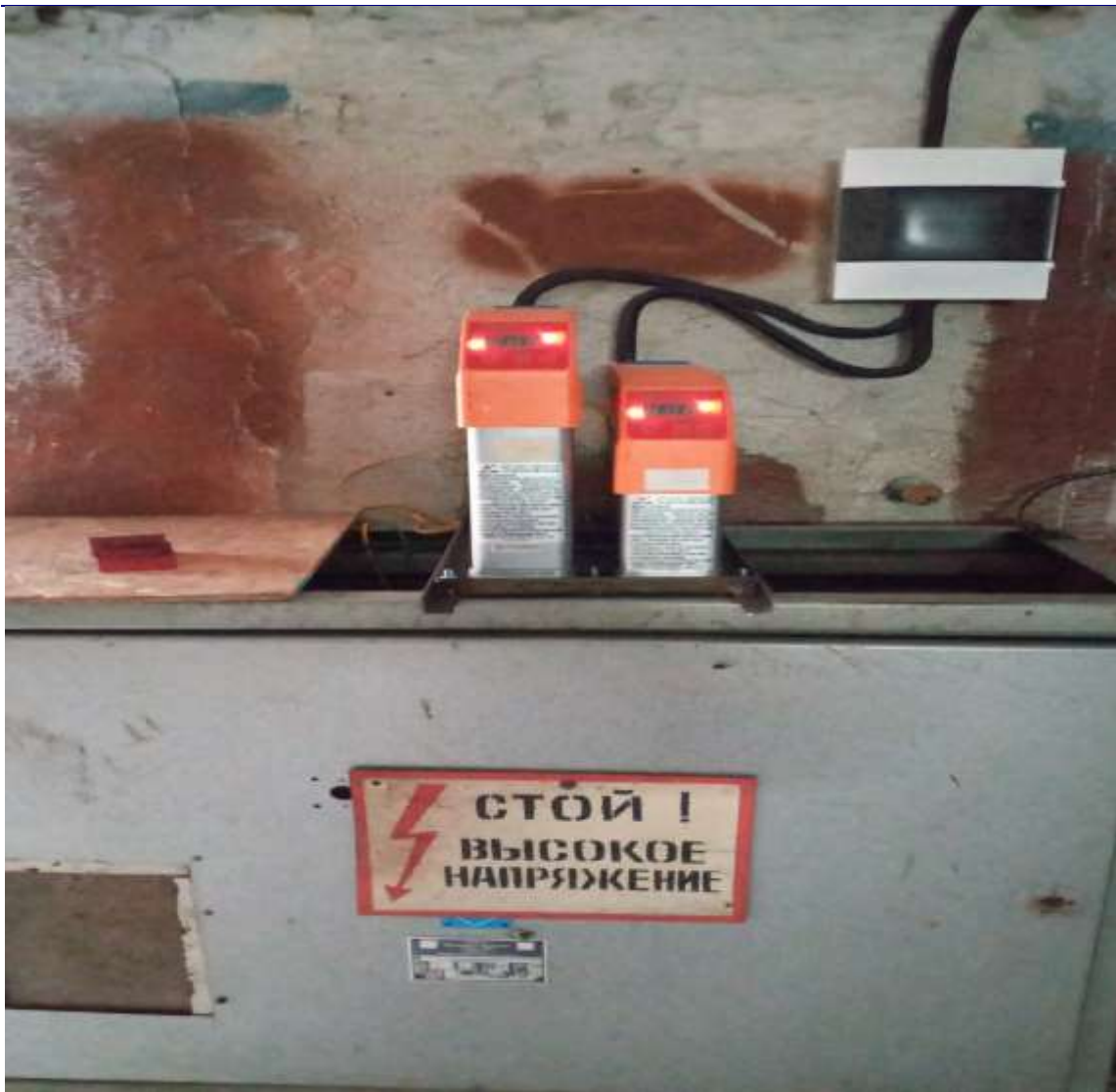
Imaginea nr. 3. Element al instalației de condensatoare de la stația de Epurare, str. V.Cupcea 5A.
