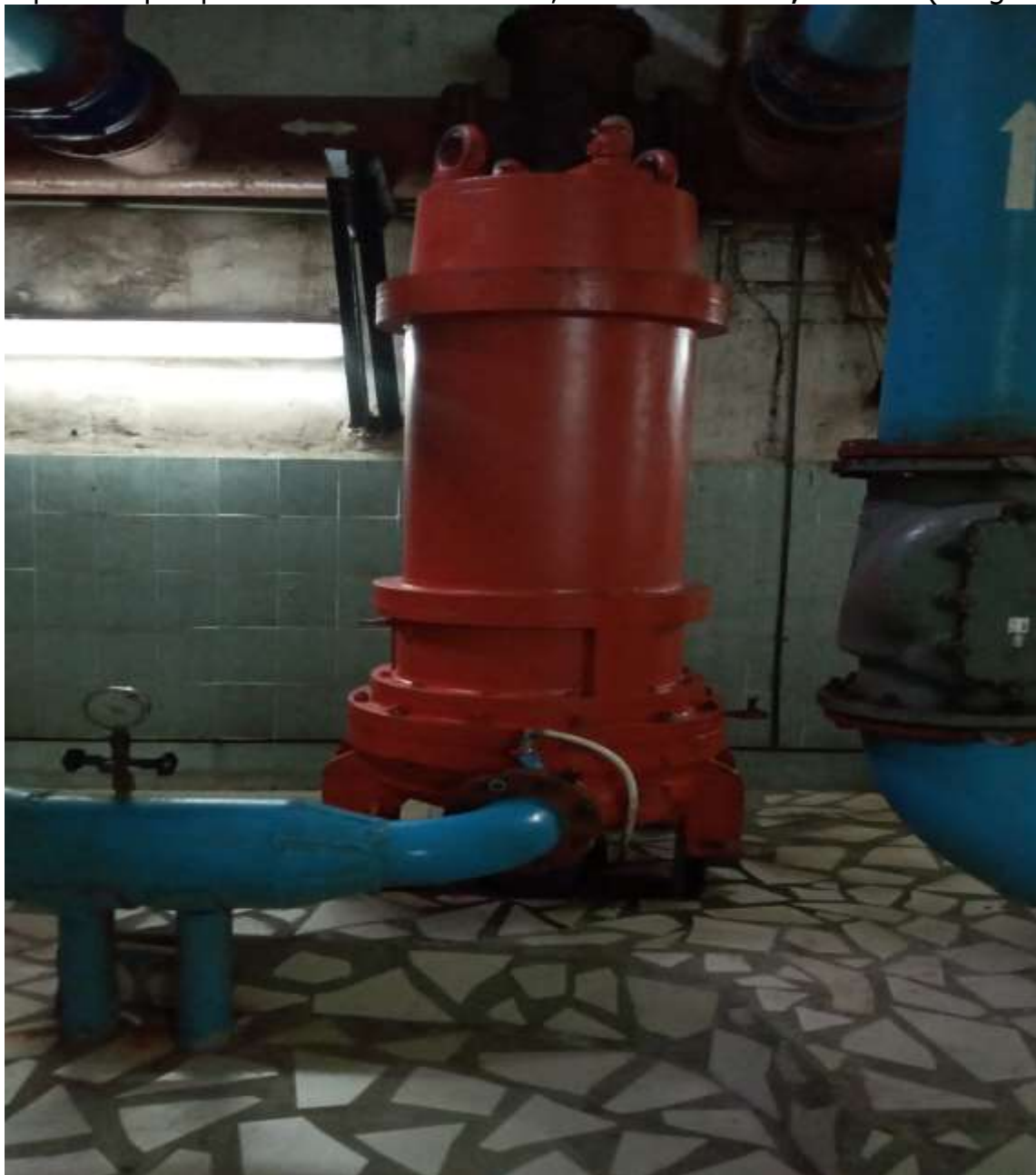
Imaginea nr. 2. Pompa WILO de la SPP Canal, supusă reparației în anul 2020.
