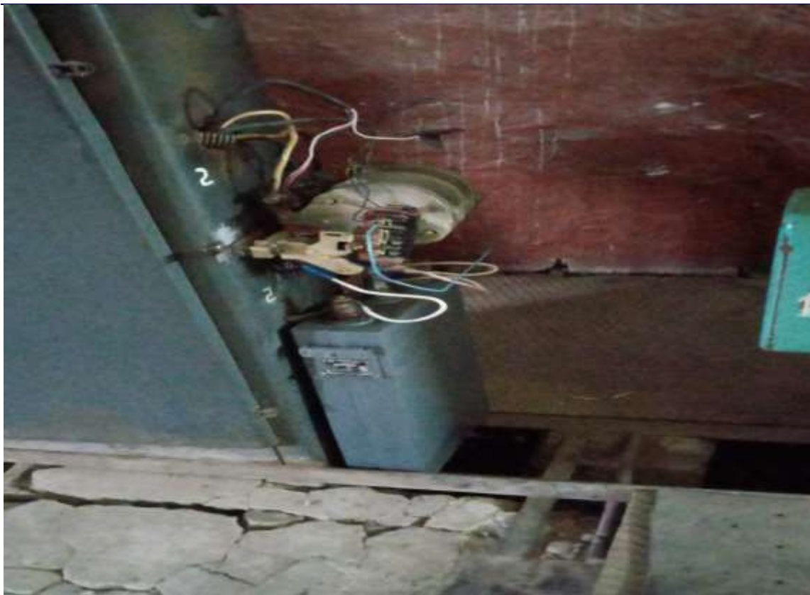
Imaginea nr. 4. Element al instalației de condensatoare de la stația de Epurare, str. V. Cupcea 5A.
